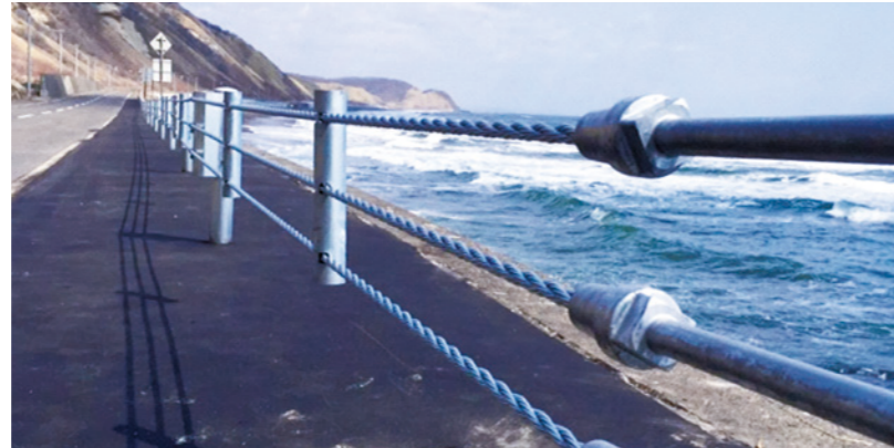
■ガードケーブル(無色透明) (北海道 浦幌地区)
