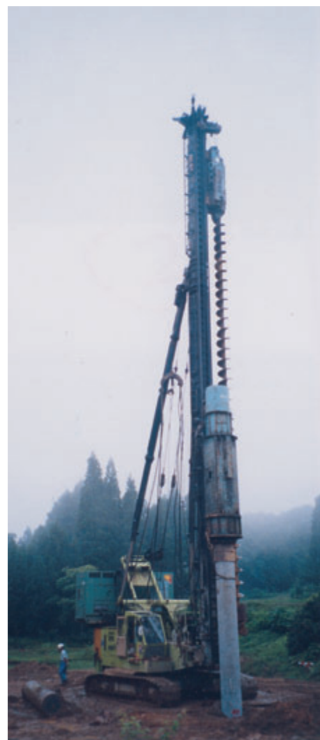
埋設工事事例
